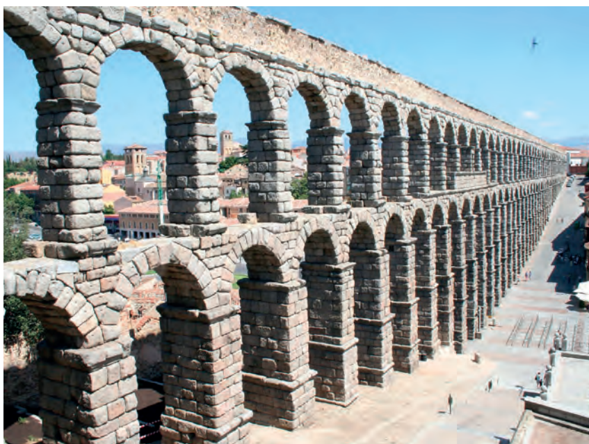
Figura 2 : Acueducto de Segovia
